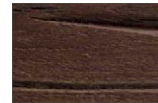
..... V verwittert (lackiert)
